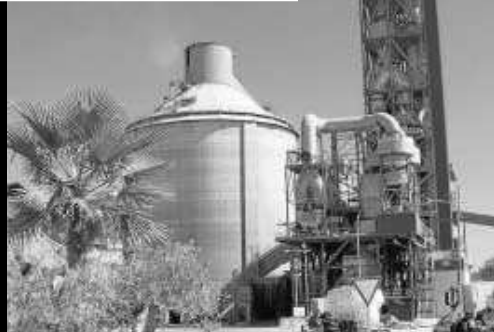
Vista exterior de la fábrica de cemento.
